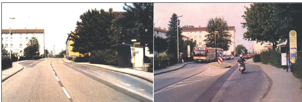
Rys. III.29. Przystanek przed przebudową (zdjęcie lewe) i po przebudowie, z wyspą pomiędzy pasami ruchu (zdjęcie prawe)
