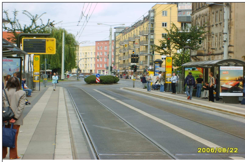
Rys. III.12. Przystanek z ułatwionym wjazdem/wyjazdem, wyposażony w podwyższone perony i dynamiczną informację pasażerską
